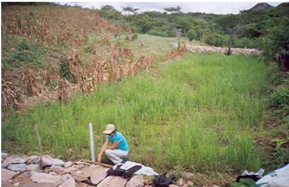
Foto 2 – Barragens de Contenção de Sedimentos
