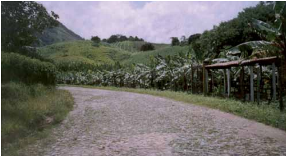
Foto 7 – Adequação de Estradas Vicinais Fonte: João Bosco de Oliveira.
