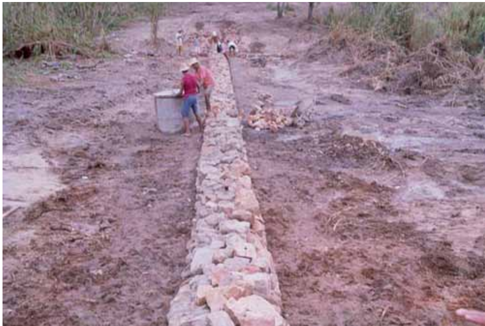
Foto 3 – Modelo de Barragem Subterrânea
